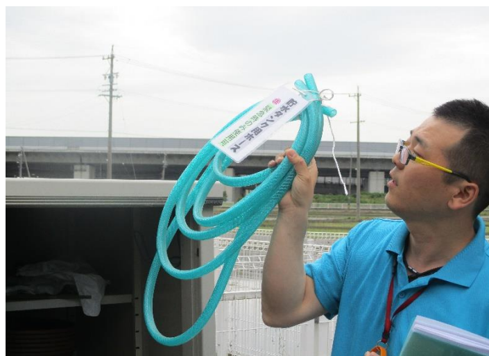
貯水槽で使用するホース保管場所
