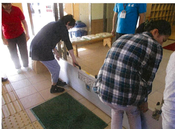
止水板の設置
