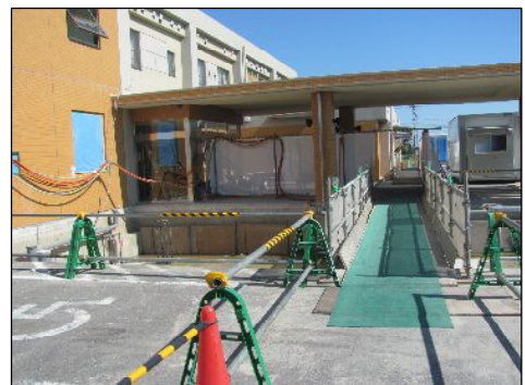
仮の正面玄関
